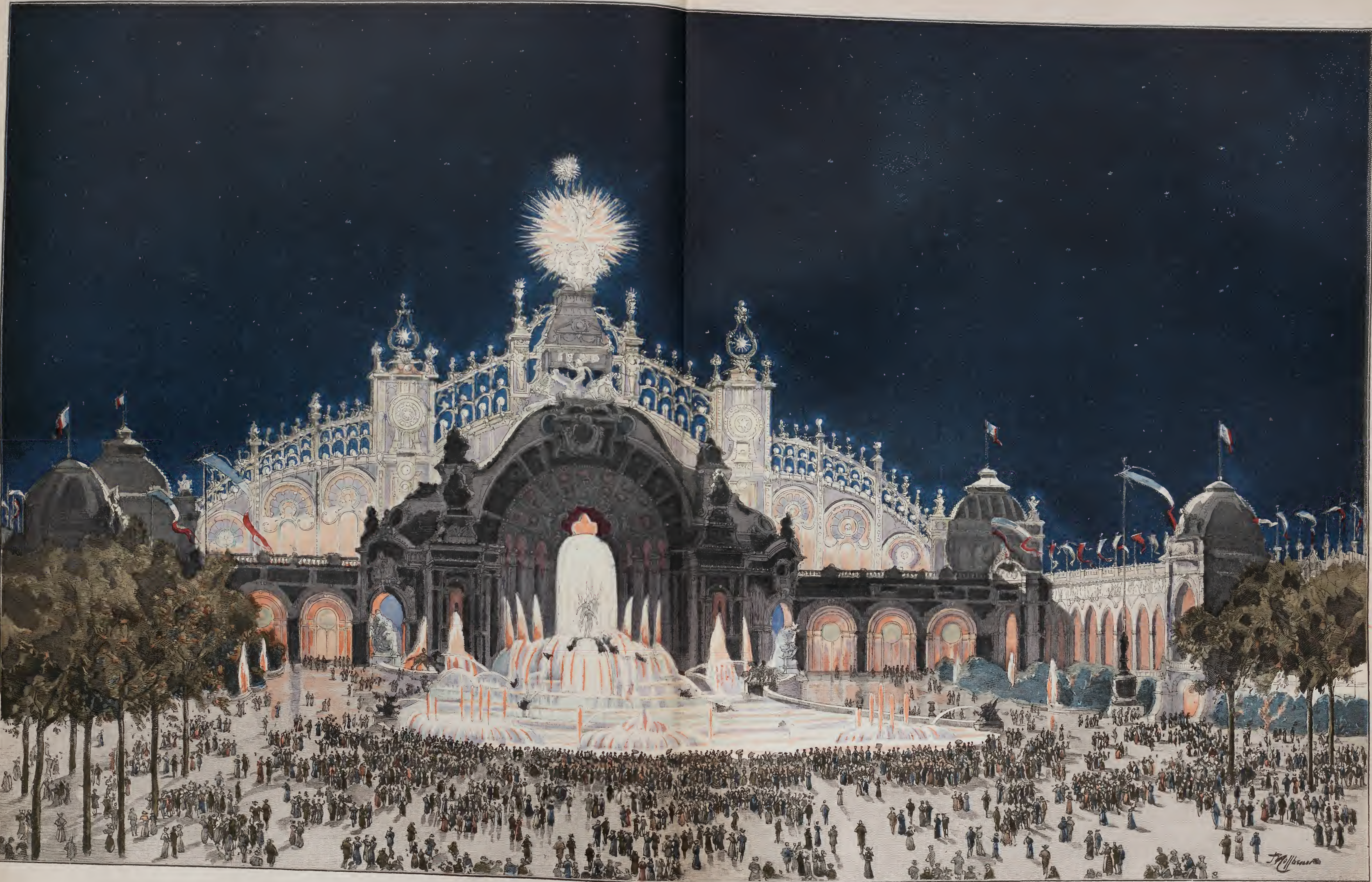
LE PALAIS DE L'ÉLECTRICITÉ ET LE CHATEAU D'EAU. — EFFET DE NUIT. — (D'après le document officiel.)
